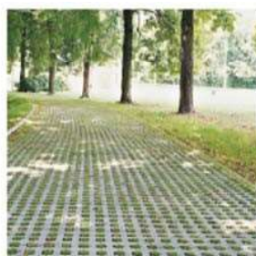
Exemples de solutions drainantes pour le stationnement
