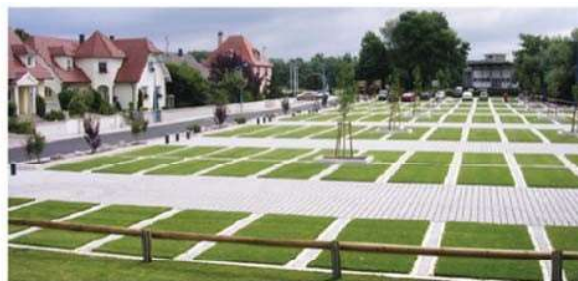
Exemples de solutions drainantes pour le stationnement
